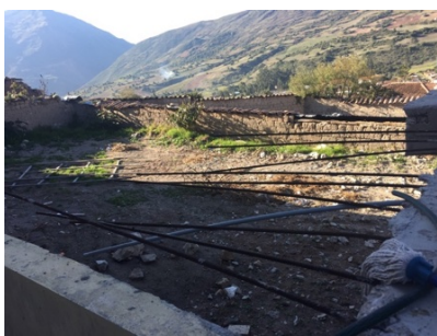
Unser zukünftiger Garten in Curahuasi – auch hier wartet Arbeit auf uns...
